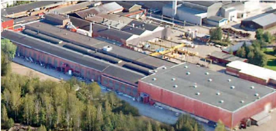
Neues Richter Werk in Karhula mit ca. 20.000 m 2 Produktionsfläche, speziell auf die Walzenfertigung von Klein- und Großwalzen bis elf Meter Papiermaschinenbreite ausgerichtet.
