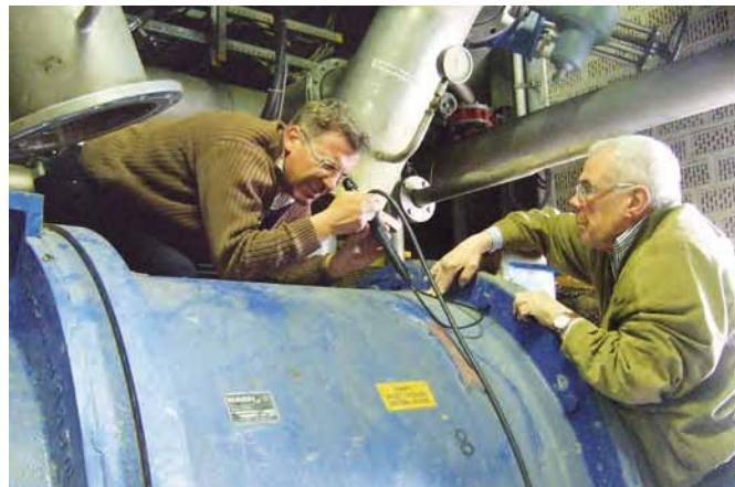
Vakuumspektion/-kapazitätstest vor Ort durch Richter-Servicetechniker
