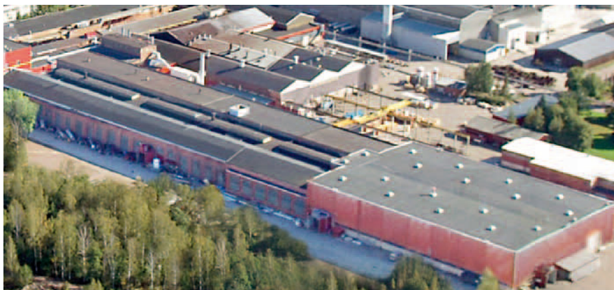
Nieuwe Richter-fabriek in Karhula met een productieoppervlak van ca. 20.000 m 2 die speciaal geschikt is voor de fabricage van kleine en grote walsen voor papiermachines tot elf meter breed
