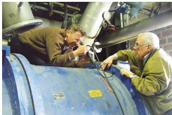
Vakuuminnspektion / kapacitetstest görs av en servicetekniker
